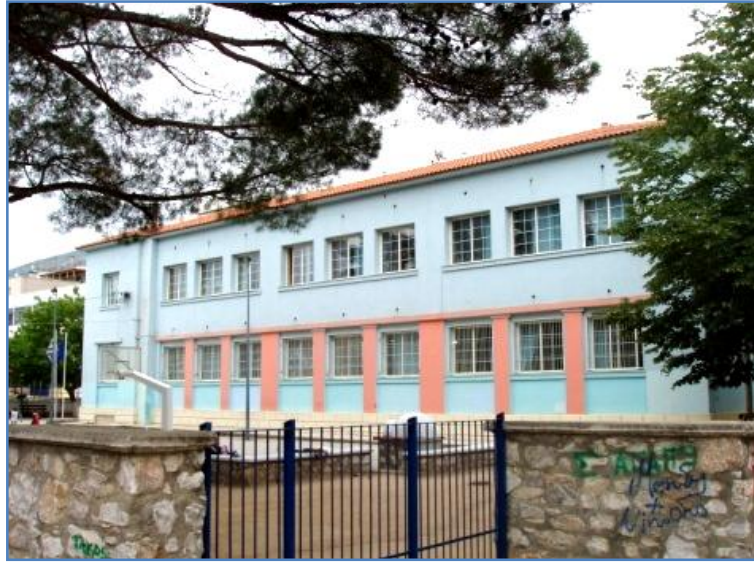
8. Δ. Κλάψης, 6 ο Δημοτικό Σχολείο, Ξάνθη, 1931-32. Άποψη της μεσημβρινής πρόσοψης.
