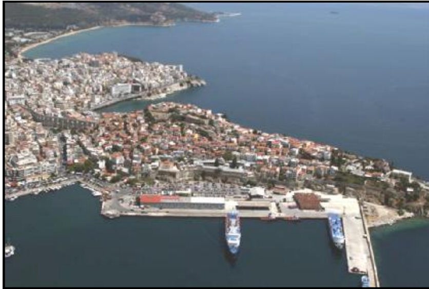
1. Καβάλα. Αεροφωτογραφία του οικισμού της Παναγίας με τη δυτική παράλια οχύρωση
